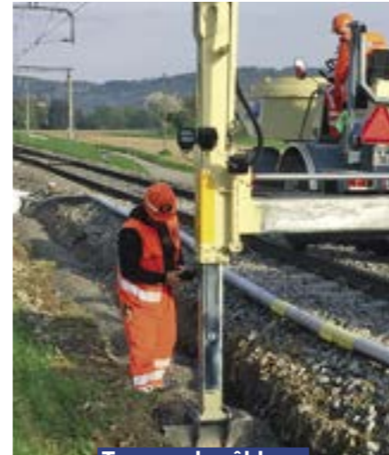
Travaux de câblage
