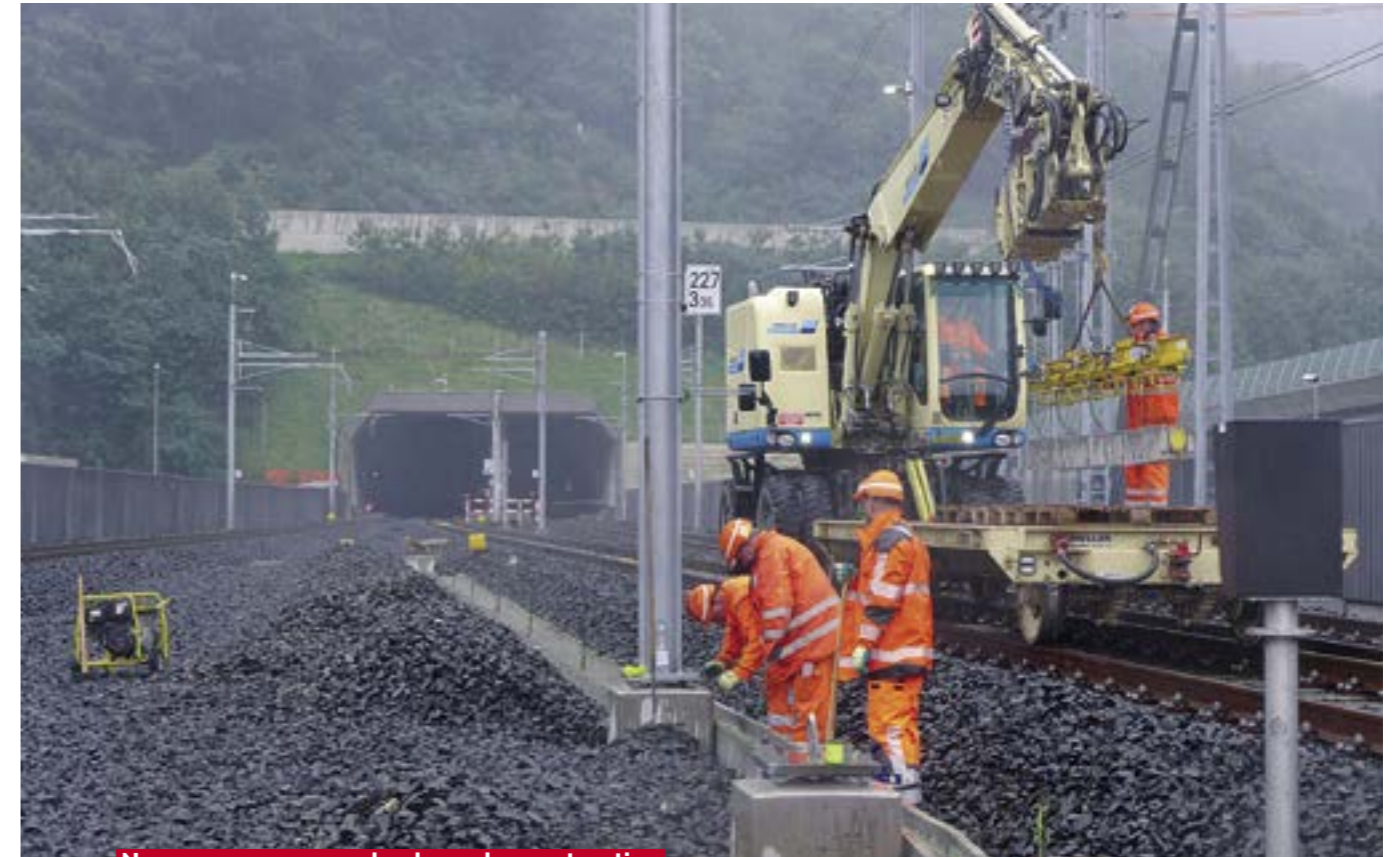
Nous accompagnons la phase de construction du début à la fin
