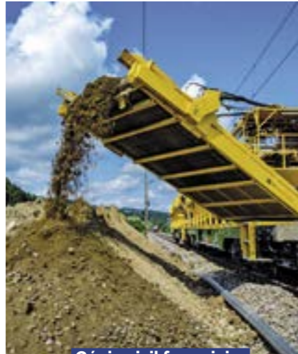
Génie civil ferroviaire
