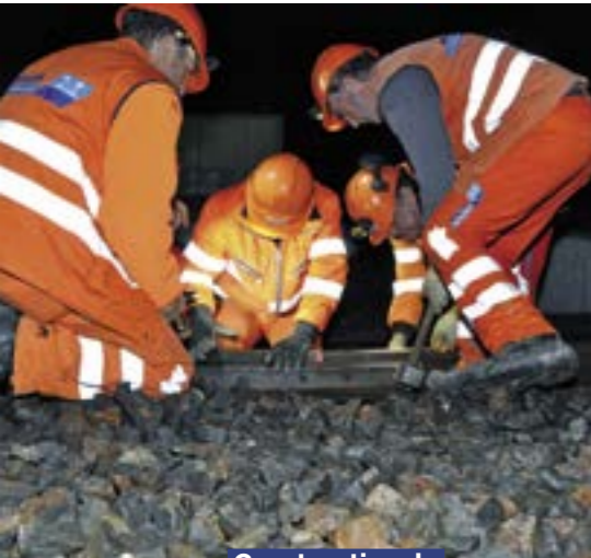
Construction de voies ferrées
